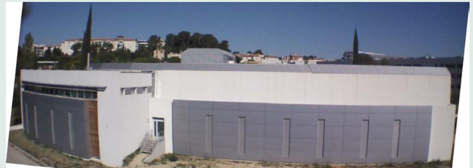
Nouvelle salle machine : 600 m 2
